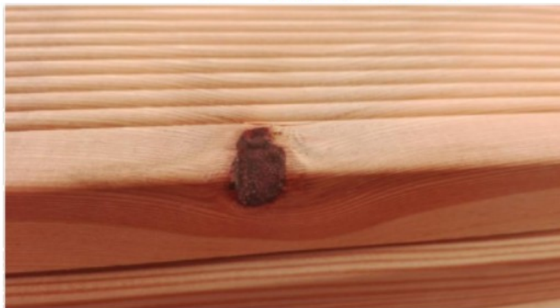
Fot. 14 - sęki boczny wypadnięty
