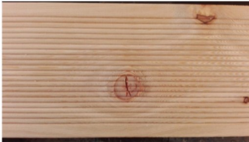
Fot. 21 - sęk spękany, wykruszony
